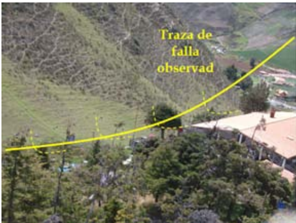
Figura 30. en referencia textual Figura 15. Trinchera de falla paralela a la carretera Trasandina.
