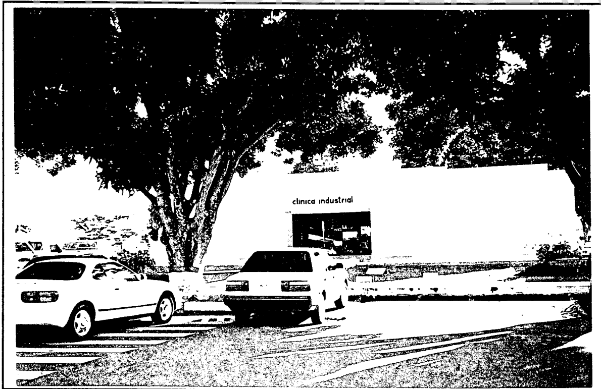
Fig. No. 15: CLÍNICA INDUSTRIAL CAMPO LA MESA, ESTADO BARINAS.
