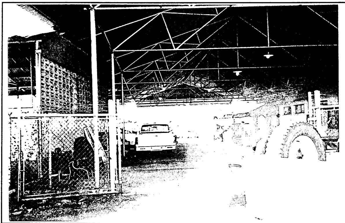
Fig. No. 12: TALLER MECÁNICO EL TOREÑO ( AUTOMOTRÍZ ), EN EL ESTADO BARINAS.
