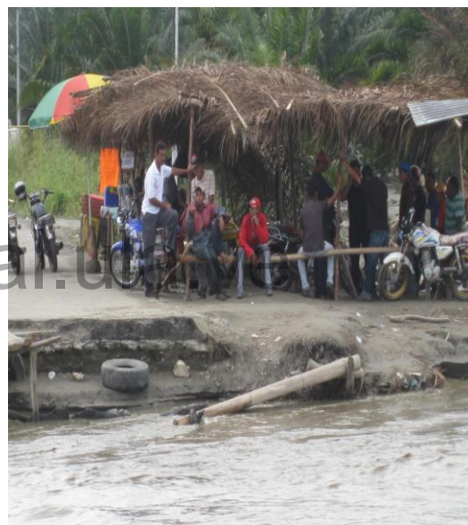
Pérdida de la vía Puerto Chama
