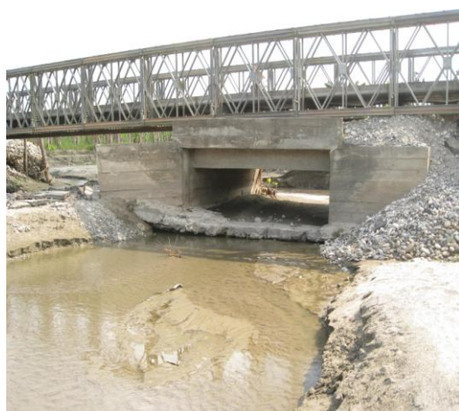
Vía Caño Blanco-Puerto Chama
