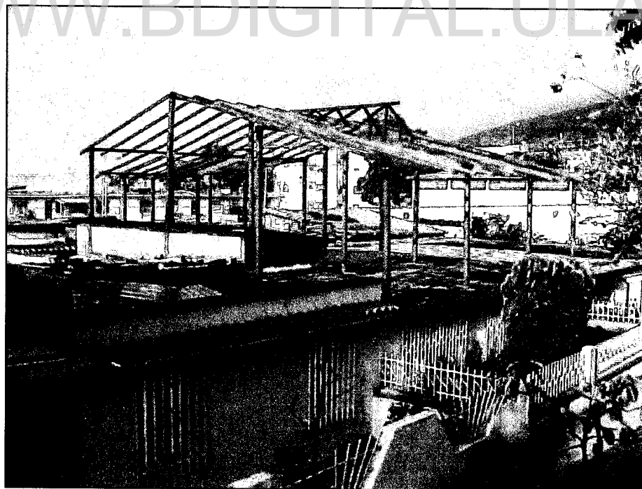
Figura N° 5.1 Ejemplo de una ampliación de vivienda que emplea perfiles tubulares de (100x100) mm 2
