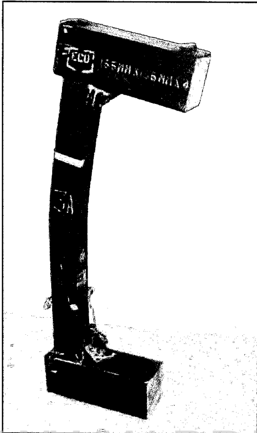
B5.- VISTA GENERAL DE LA COLUMNA REFORZADA DESPUES DE LA FALLA
