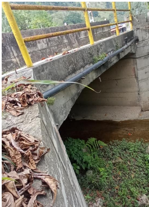
Figura 108. Puente de concreto armado en quebrada El Barro
