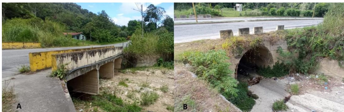
Figura 16. Cajón de paso y alcantarilla.
