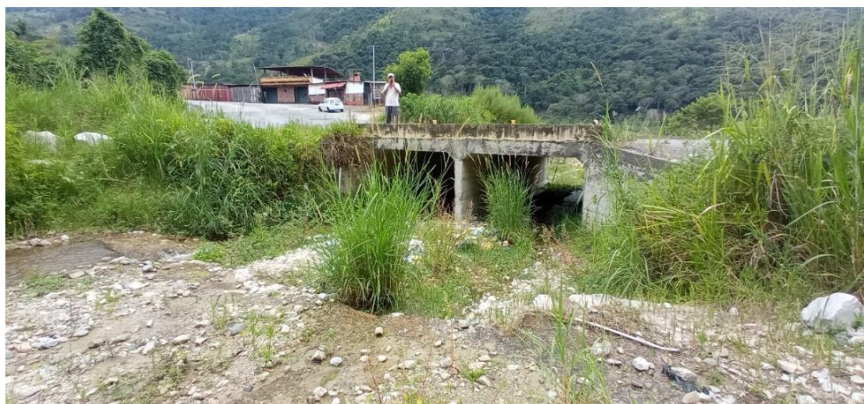
Figura D.2 2. Cajón de dos celdas. Presencia de rocas de gran tamaño
