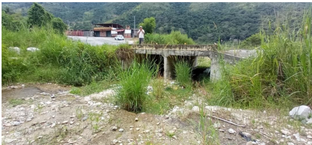
Figura 12. Obra de paso en quebrada El Peñón/San Rafael
