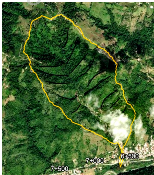
Figura 38. Cuenca: quebrada No identificada. Progresiva 6+500
