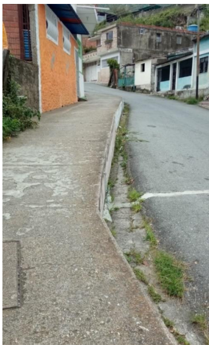
Figura D.5 1. Vista del trazado del sistema de drenaje entubado
