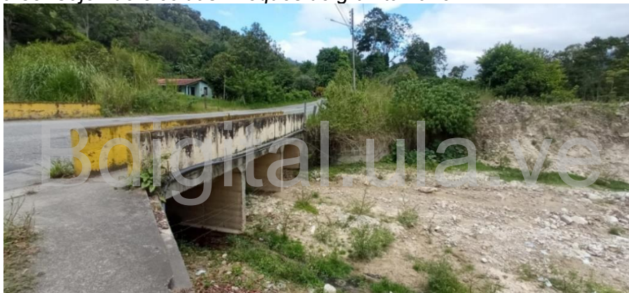
Figura 55. Cajón de 3 celdas. Bloques de gran tamaño
