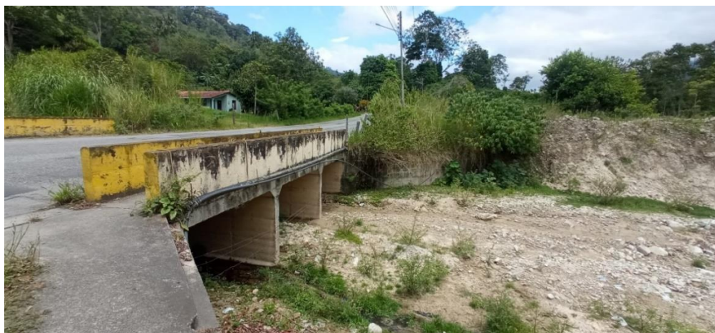
Figura 99. Obra de paso en quebrada Cacagüito
