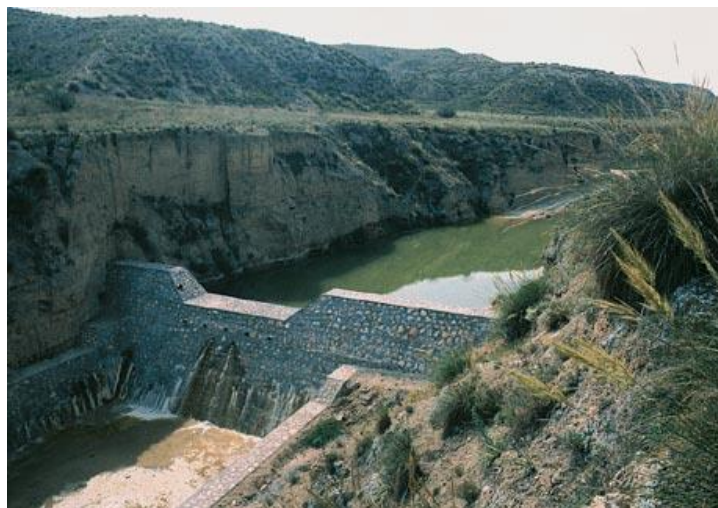
Figura 3. Dique de retención de sedimentos. Santa Cruz de la Zarza, Toledo, España
