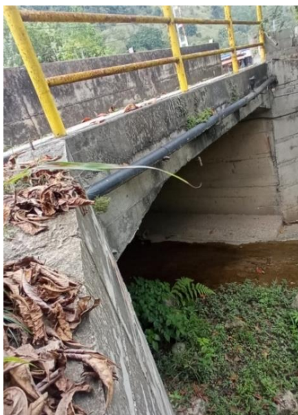
Figura 61. Puente de concreto armado en quebrada El Barro
