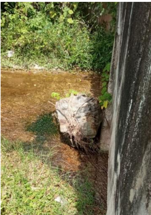
Figura 53. Filita de gran tamaño golpeando el pilar central
