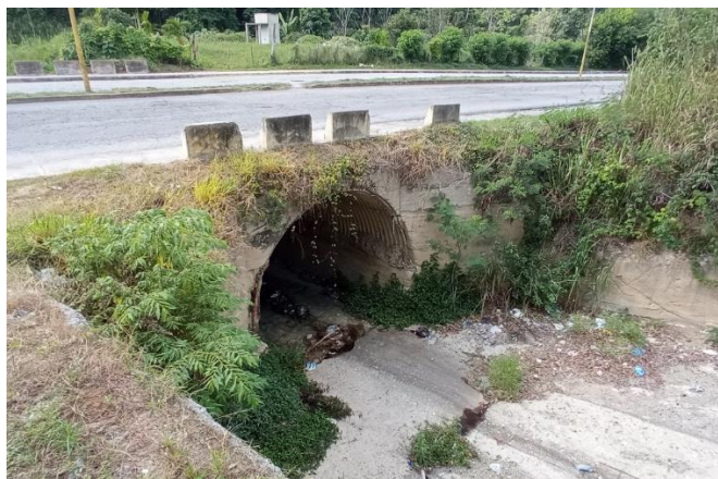
Figura 103. Alcantarilla de arco metálico corrugado revestida en concreto en cabezales y laterales
