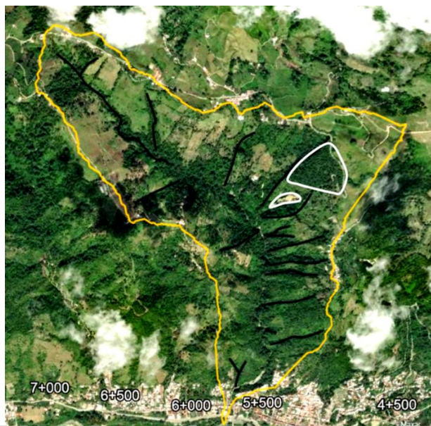
Figura C.2 1. Cuenca: quebrada Carmania/Los Cedros. Progresiva 5+500 – 5+750
