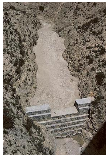
Figura 4. Dique de retención de sedimentos. Barranco de las Ovejas, Alicante, España
