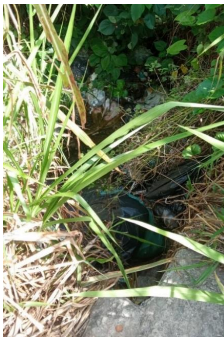
Figura 49. Salida obstruida por vegetación y desechos sólidos
