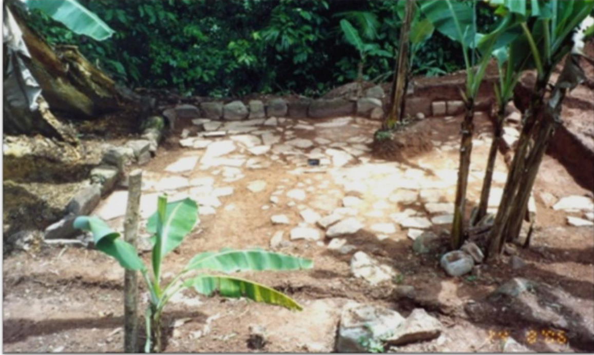
(Foto 6) Estructura sector La Blanca, aldea Caliche, municipio Ayacucho
