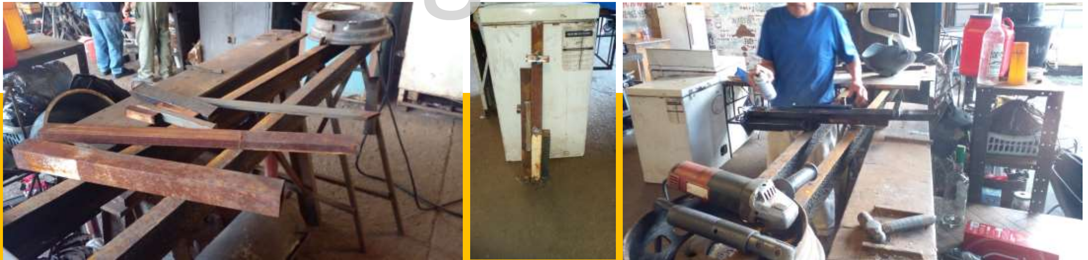
FIGURA 98 Proceso de Ejecución de la Obra
