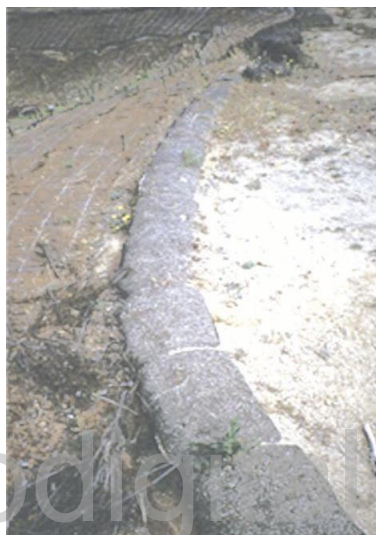
Figura C.6. Vista en perspectiva del tratamiento lineal con sacos de tierra.
