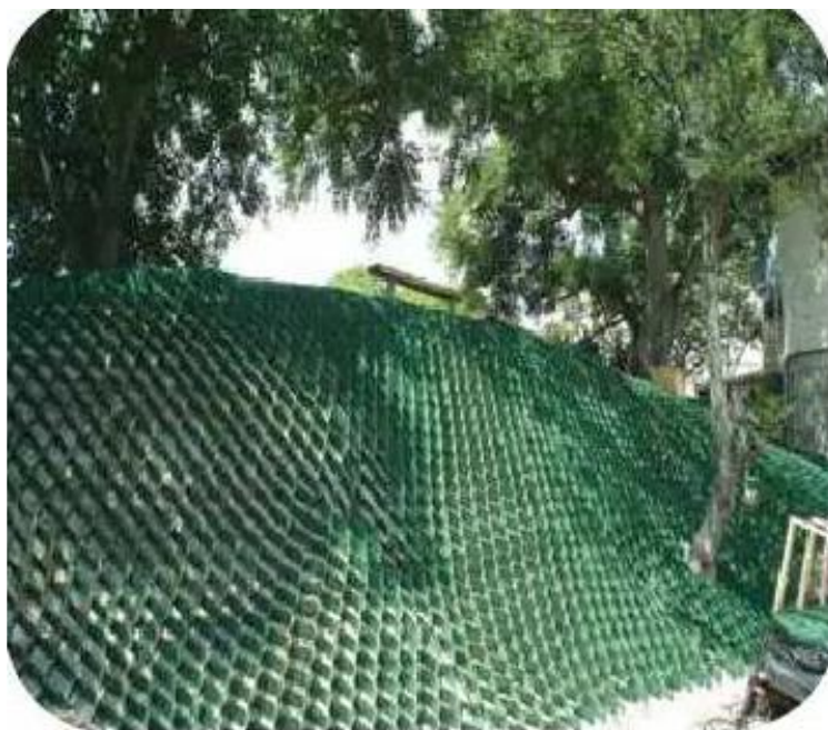
Figura B.6. Geoceldas extendidas sobre la base del talud.
