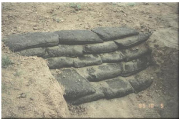
Vista detalle de tratamientos con muro de sacos
