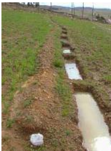
Figura C.2. Zanja de infiltración.
