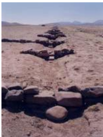
Figura C.3. Presa de contención de piedras en cárcava.
