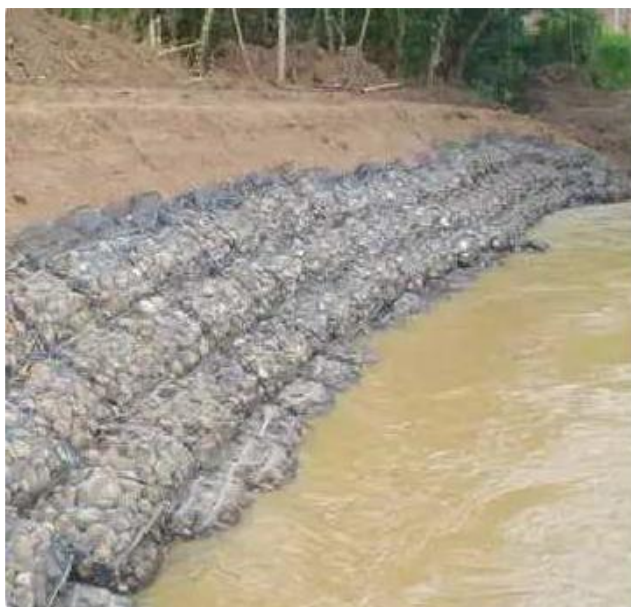
Figura C.8 Geocolchones extendidas sobre la base del talud
