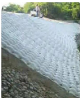
Flexocretos extendidos sobre el talud
