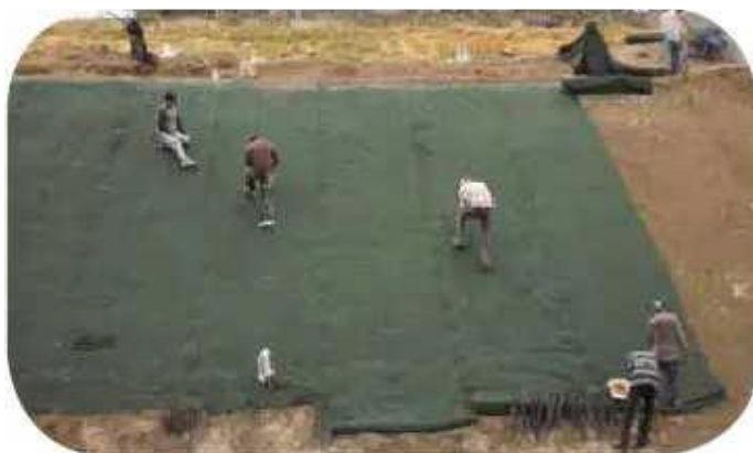
Figura B.5. Geomantas extendidas sobre el talud.
