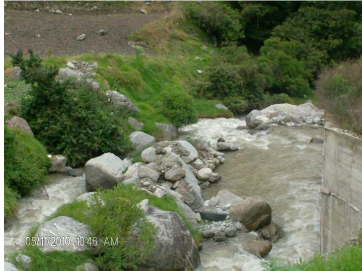
Imagen 3. Río Motatán, se puede apreciar en muro de contención que da seguridad a la U.E. Emilio Maldonado (Chachopo).
