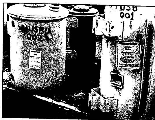
Figura 4.3. Identificación y etiquetado de los equipos. Patio de Salvamento Bachaquero.
