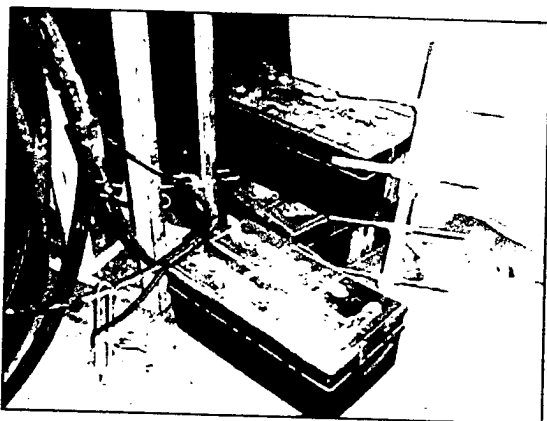
Figura 4.17. Vista General de Baterías. Taller de Reparación de Radios. Telecomunicaciones, San Francisco.
