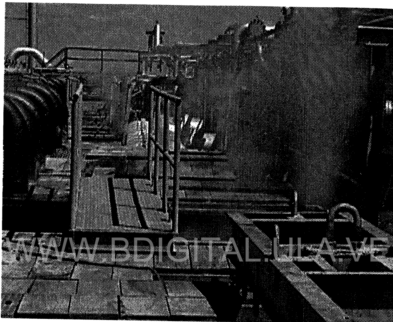
Foto N° 5.20 Presencia de Gas en la Parte superior de los Enfriadores Atmosféricos
