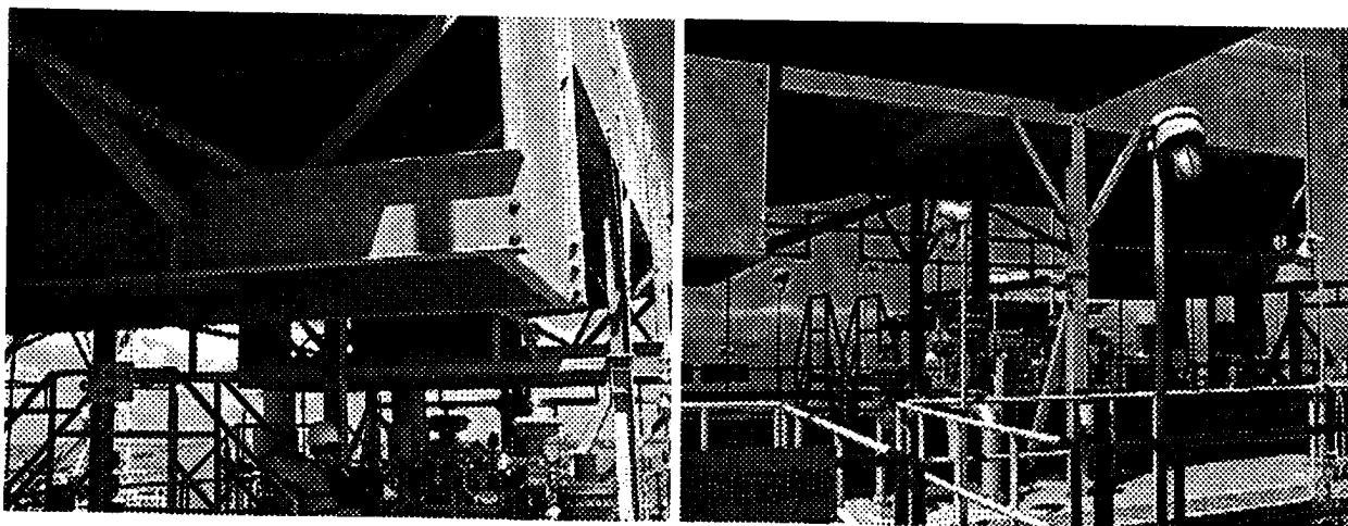
Foto N° 5.18 Enfriadores de Gas por Aire forzado de los Módulos de Etano donde se utiliza el Abrillantador de Aluminio
