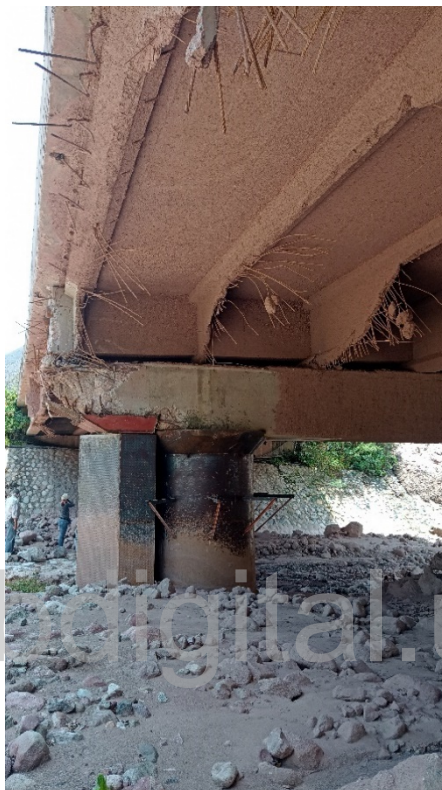
Figura 44. Vigas y pila de puente El Anís. Fuente propia.
