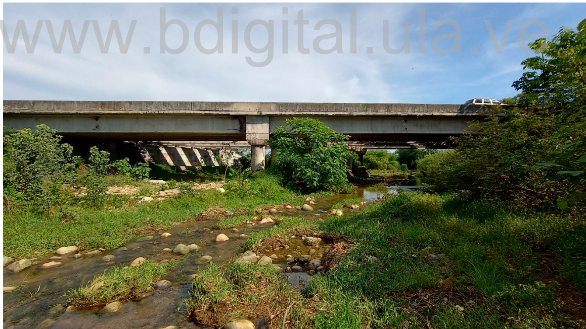
Figura 32. Puente Balsa. Fuente propia.
