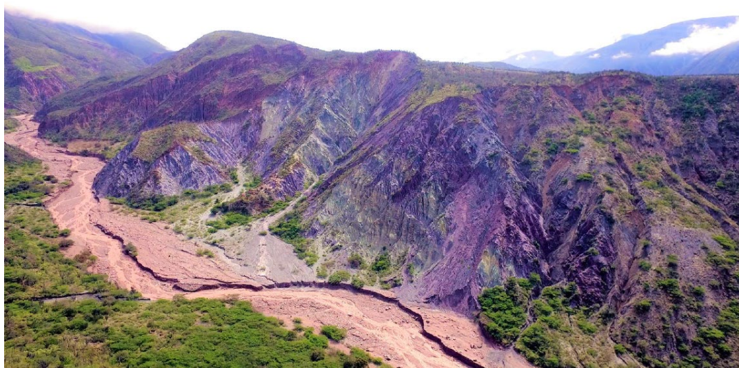
Figura 49. Zona aguas arriba de la estructura. Fuente: Gobernación del estado Mérida (2023).
