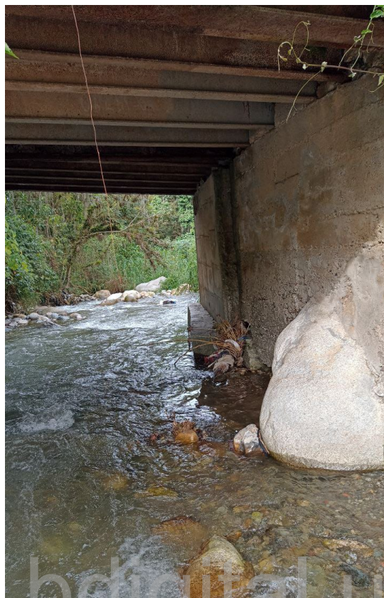
Figura 53. Estribo derecho, puente Cruz Verde. Fuente propia.
