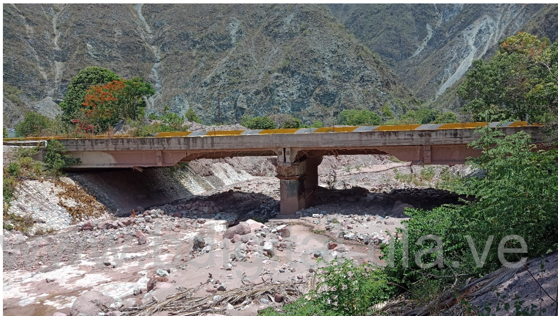
Figura 43. Puente El Anís. Fuente propia.
