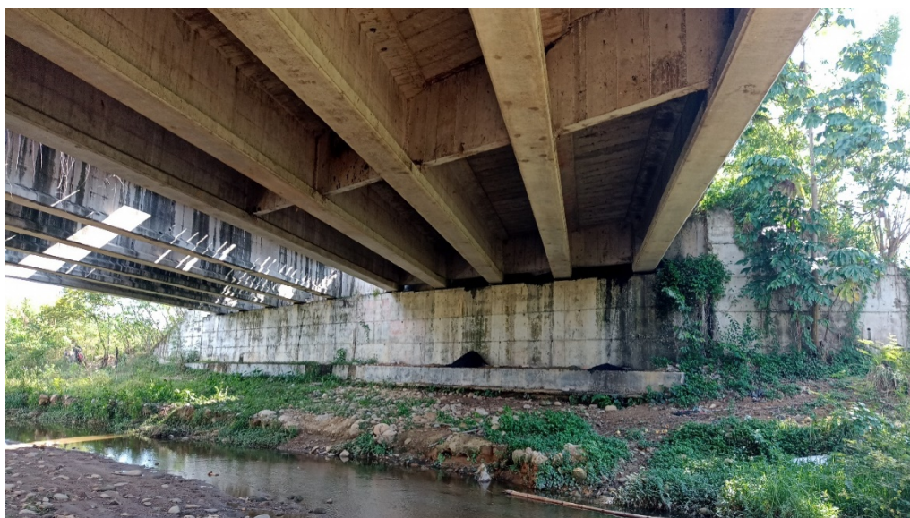
Figura 34. Estribo derecho, puente Balsa. Fuente propia.
