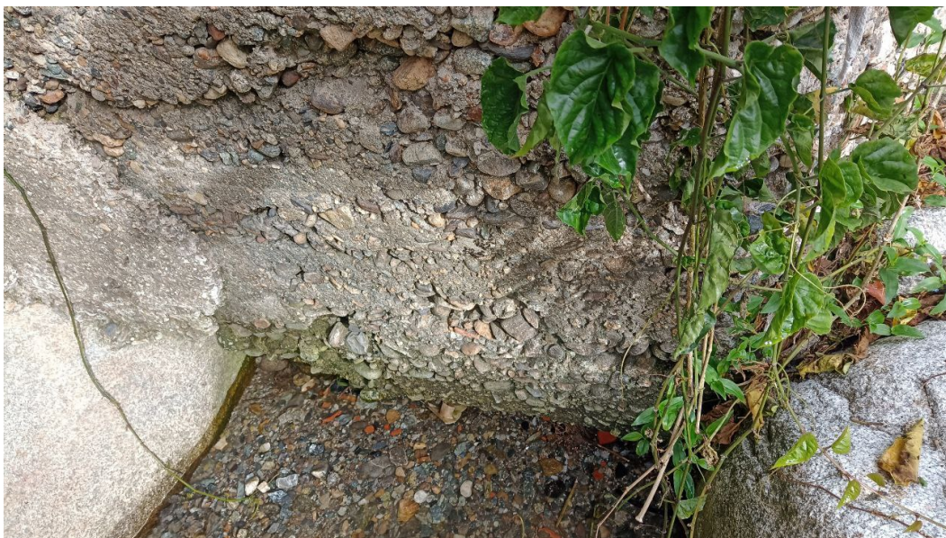
Figura 54. Detalle de estribo derecho, puente Cruz Verde. Fuente propia.
