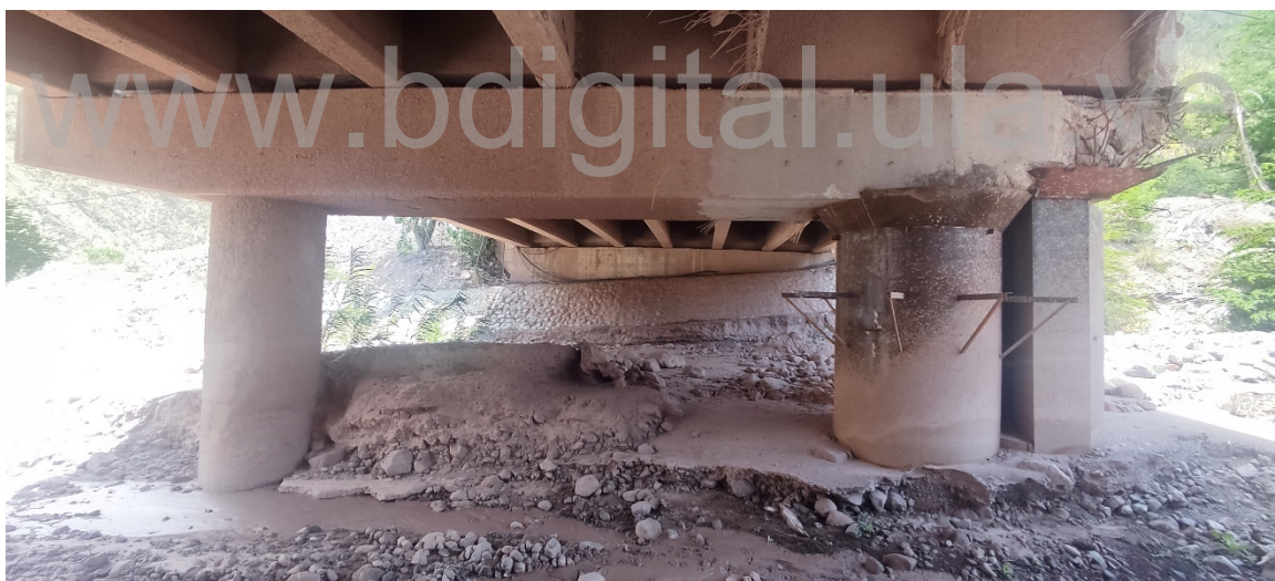
Figura 48. Pilas puente El Anís. Fuente propia.
