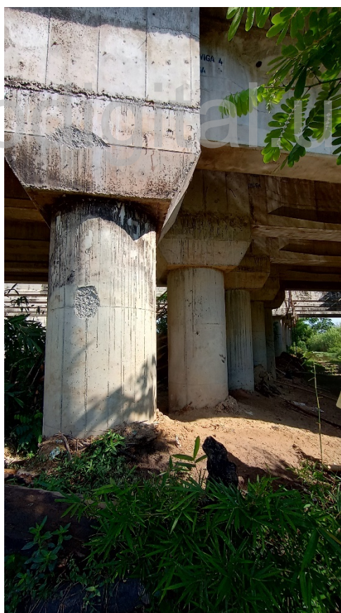
Figura 35. Pilas de puente Balsa. Fuente propia.
