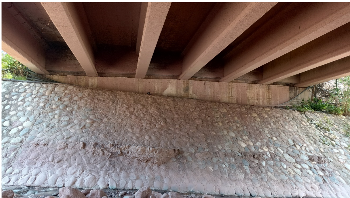
Figura 47. Estribo izquierdo, puente El Anís. Fuente propia.
