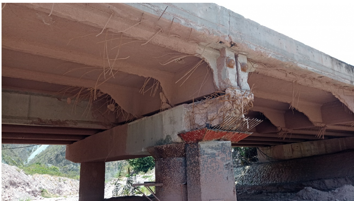
Figura 45. Reparación de pila aguas arriba de puente El Anís. Fuente propia.
