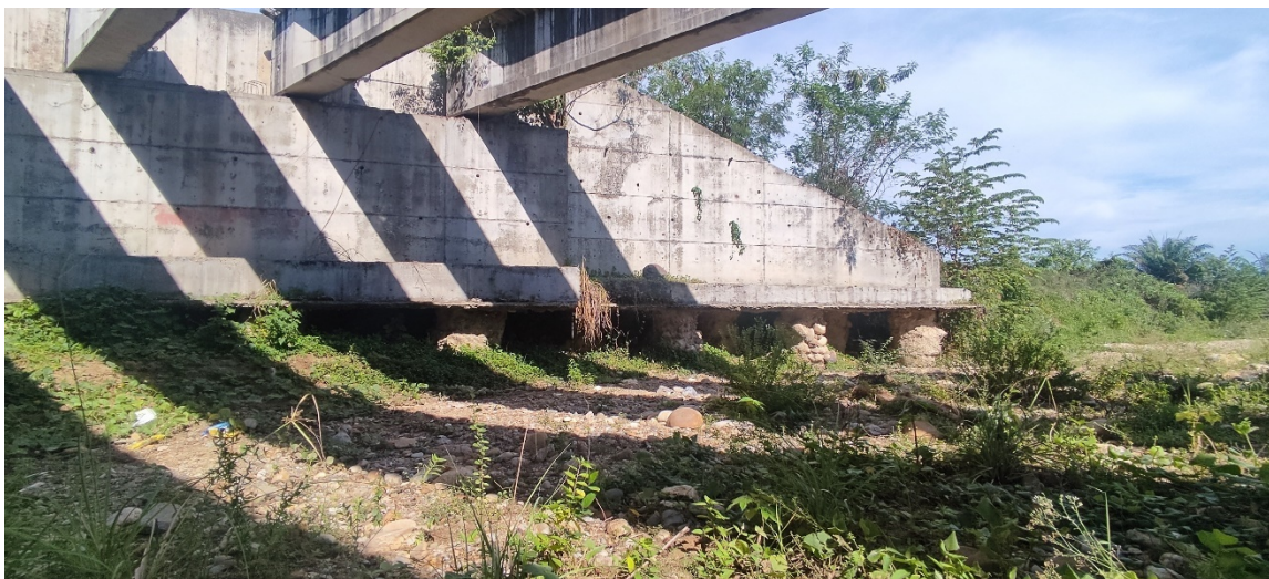
Figura 37. Estribo izquierdo, puente aguas abajo Caño Balsa. Fuente propia.
