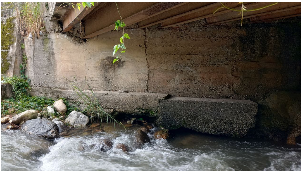
Figura 55. Estribo izquierdo, puente Cruz Verde. Fuente propia.
