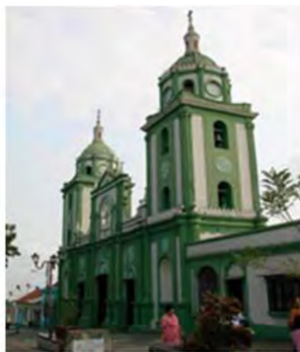
Iglesia San Juan Bautista de Betijoque
