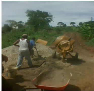
Figura19: En Plena Construcción de las Cunetas.
