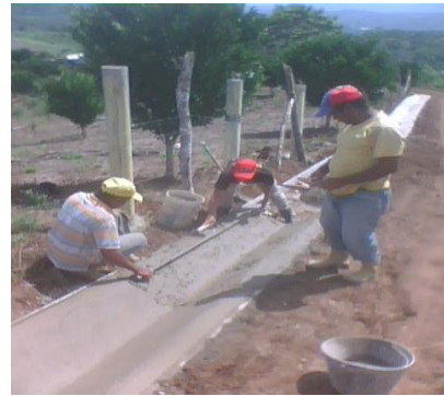
Figura19: En Plena Construcción de las Cunetas.
