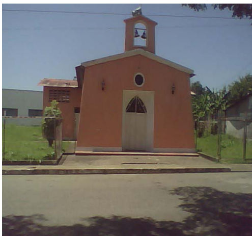
Iglesia de Quebrada Seca Construida
