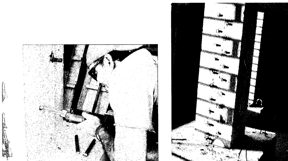
Figura 80: Colocación de epoxi en orificios, anclaje de conectores y proceso de secado.
