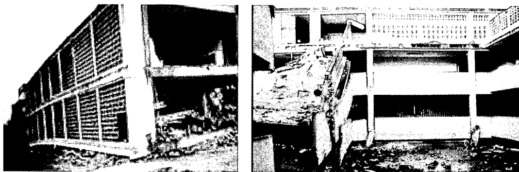
Figura 63: Colapso del Liceo Raimundo Martínez Centeno [8].
