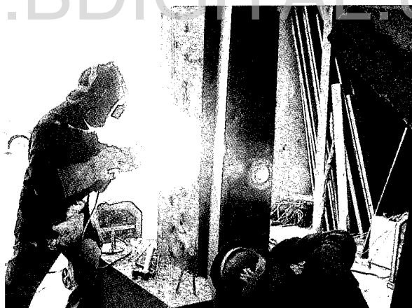
Figura 83: Soldadura de conectores a la plancha.
