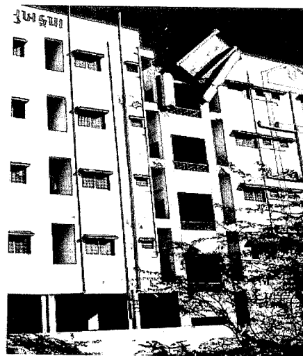
Fig. 2.9.- Falla de columna corta.
