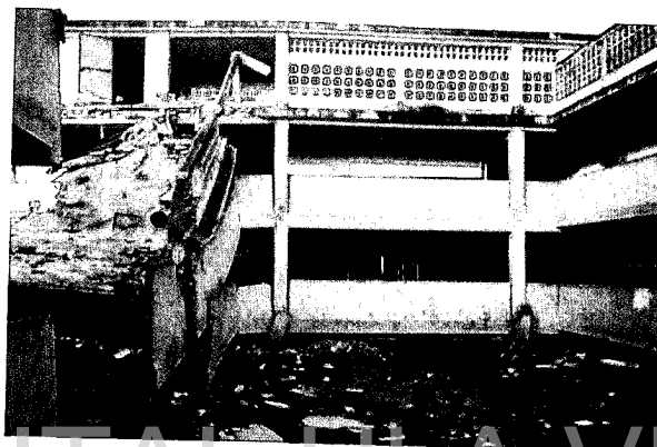
Fig. 2.17.- Liceo Raimundo Martínez en Cariaco, colapsado completamente.
