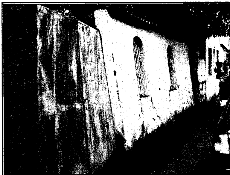
Fotografía 2. Falla de muro de mampostería.
