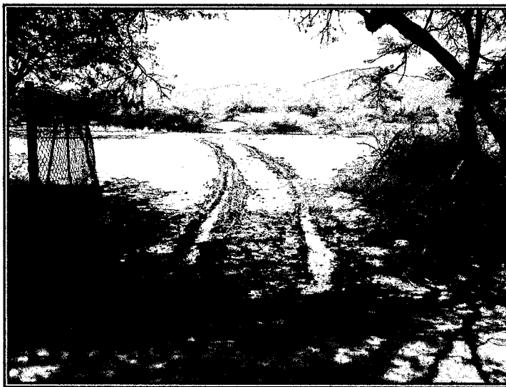
Fotografía 7. Muestra de la pérdida de capacidad de carga de la capa superficial.
