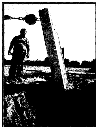
Fotografía 23. Colapso del muro en suelo húmedo
