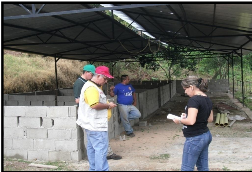
Foto 2. Inspección a la construcción de una infraestructura para el establecimiento de una cochineria, sin la autorización del M.P.P.A.
