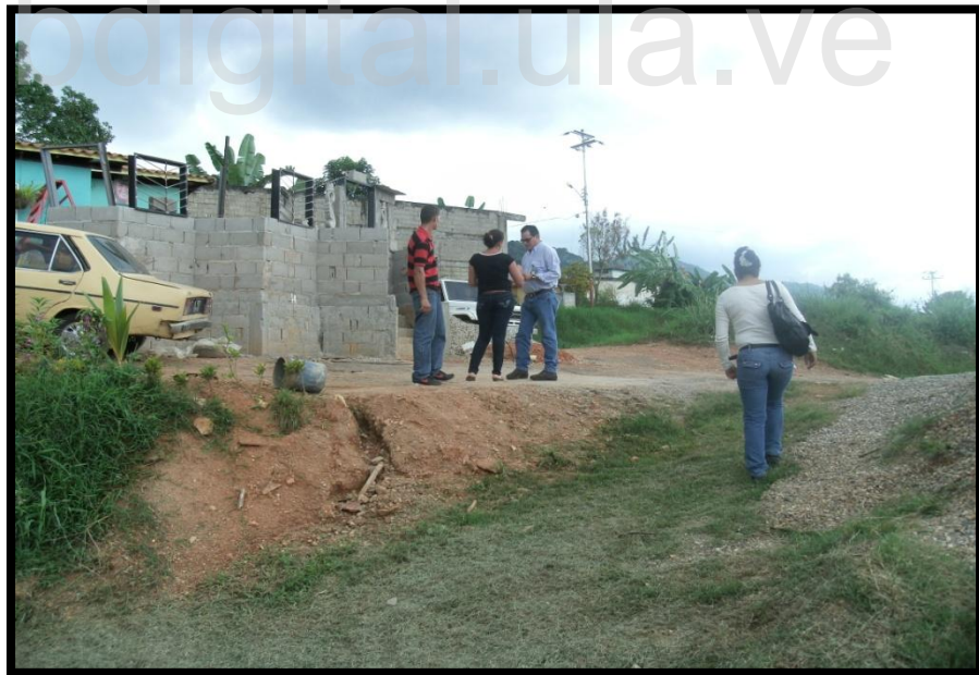
Foto 6. Detalle de movimiento de tierra, por apertura de vía que afecta la vivienda en el sector Las Terrazas de San Francisco (El Chaito), parroquia Flor de Patria.
