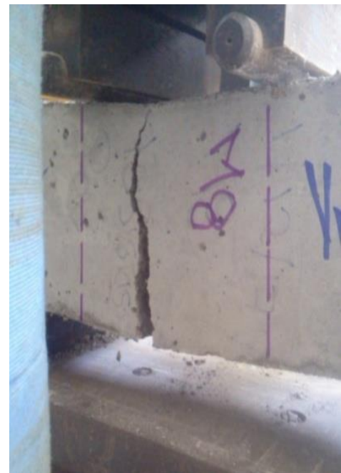
Figura 3. Falla de la biqueta en el tercio central.
