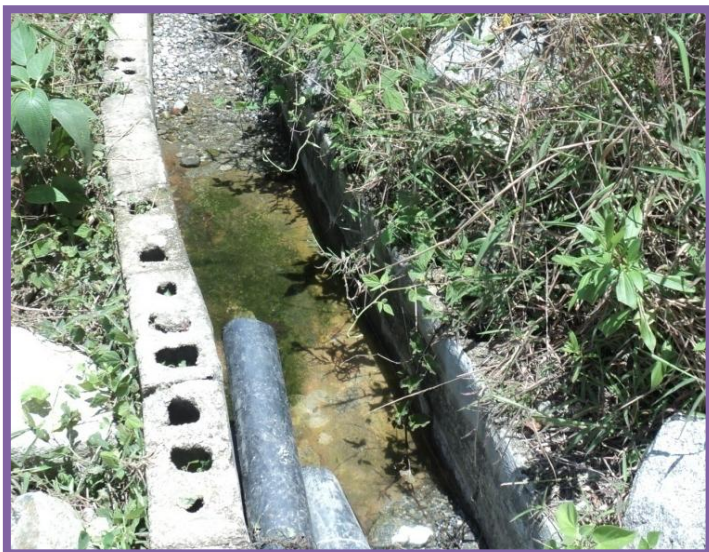
Foto N° 10: Inicio del Canal de Riego.
