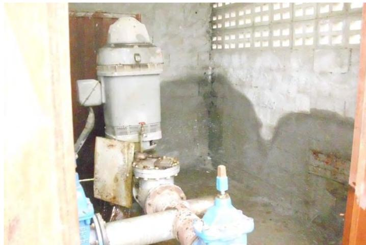
**Figura 4.1. Bomba de extracción de agua subterránea.**
