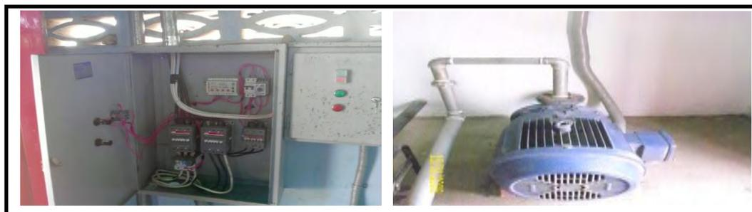
Figura 4.3. Sistema eléctrico y de bombeo
