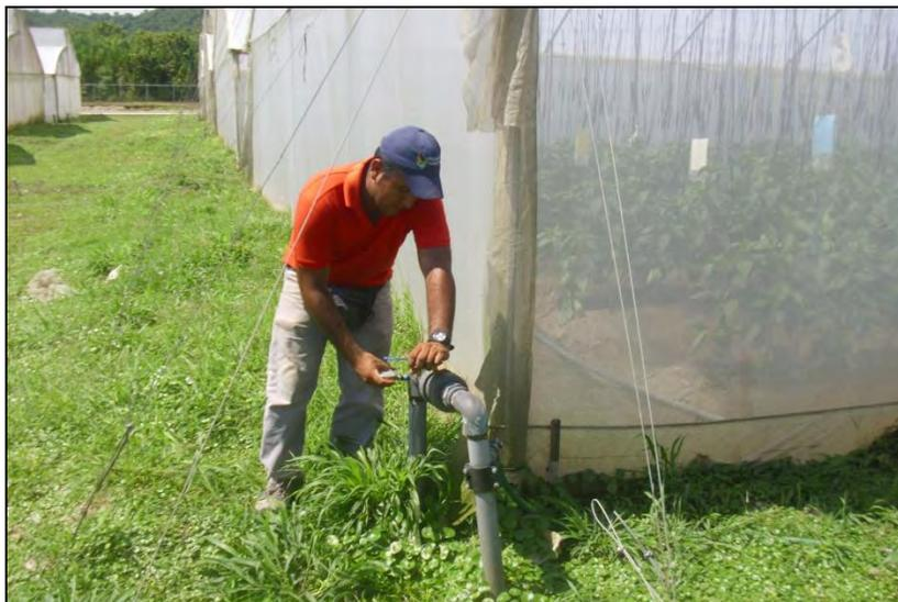
**Figura 6.7. Ajuste de la presión a 10 psi en la entrada a la unidad de riego para comenzar la evaluación.**
