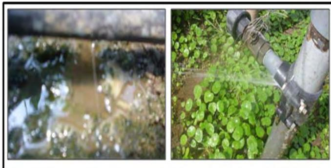
**Figura 6.13. Laterales e hidrantes con fugas**
