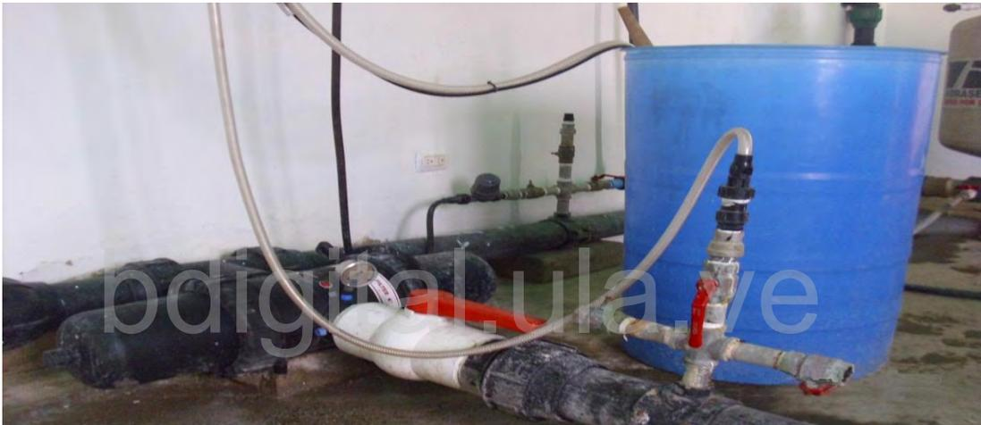
**Figura 4.11. Válvulas en el cabezal.**
