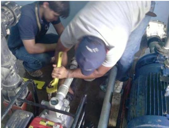
**Figura 5.18. Instalación de la bomba auxiliar.**
