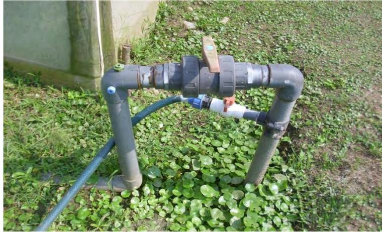
**Figura 4.12. Válvulas en el sub-cabezal.**
