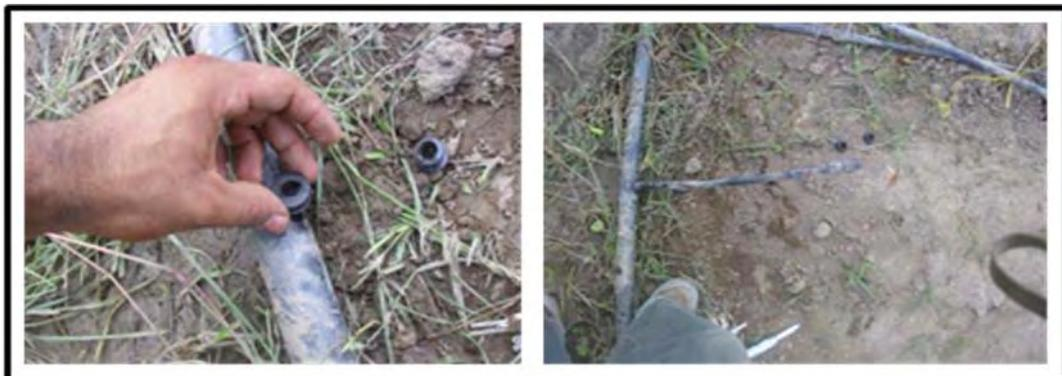
**Figura 5.16. Instalación de empacaduras y latiguillos.**
