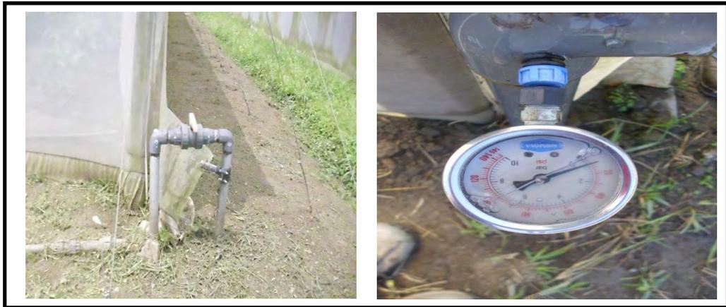
**Figura 4.8. Manómetros en los sub-cabezales.**
