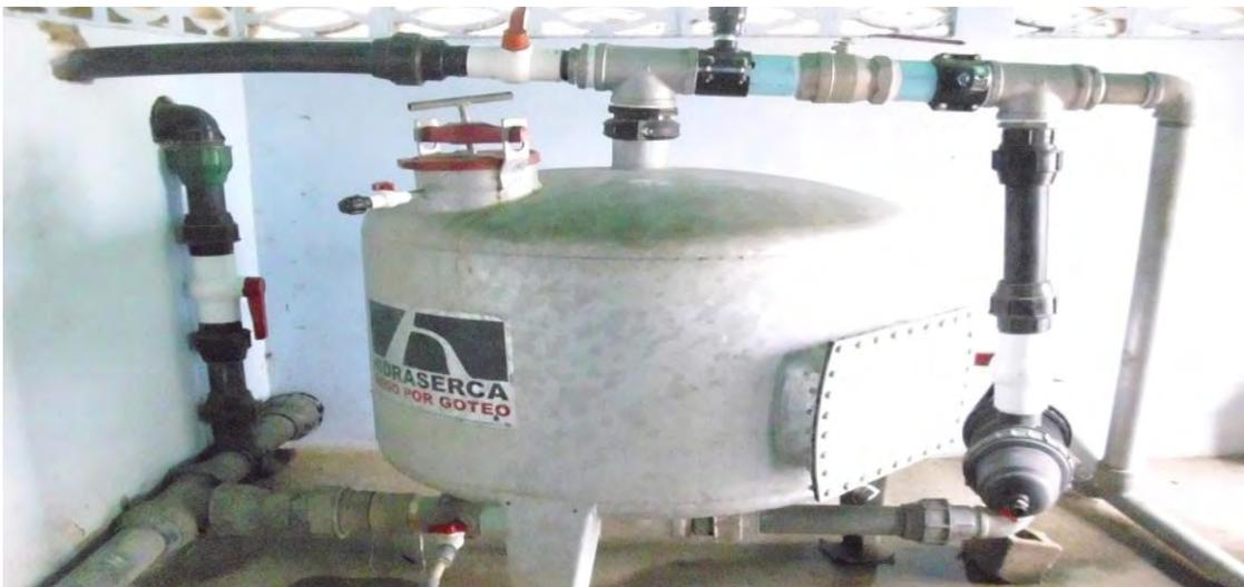
**Figura 4.10. Válvulas de regulación en el filtro de grava.**
