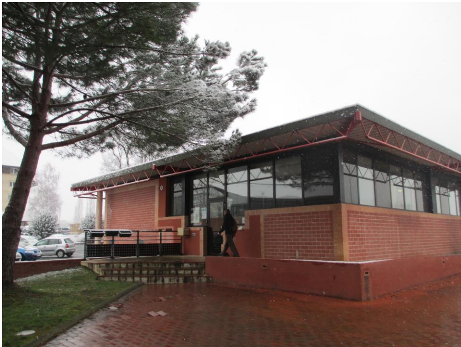
Edificio del Departamento de Formación Continua donde se encuentra Langues & Conseils.
