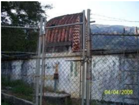
Foto14: Tanque de almacenamiento
