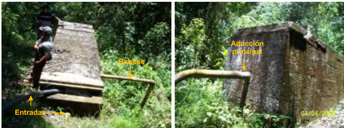
Foto 8 Y 9: Caja O Desarenador Existente
