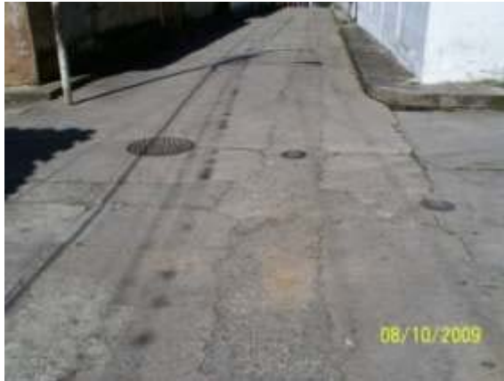
Foto16: distribución de la tubería
