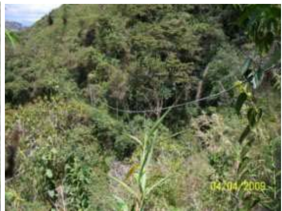
Foto11: Tubería de 3", en buenas condiciones, suspendida en puente de guaya.
