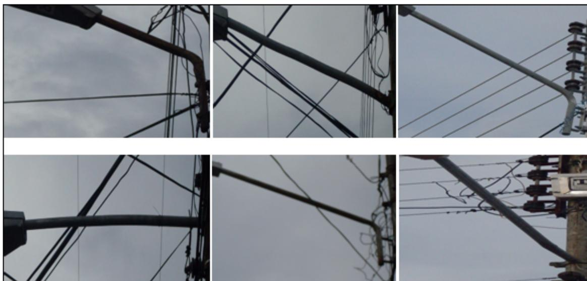
**Fig. 0.2 Brazos con Diferentes Ángulo de Inclinación Usados en el Casco Central.**
