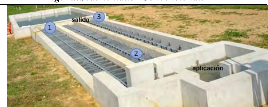
Fig. 1b: Floculador de Tabiques de Flujo Horizontal.
