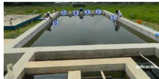
Fig. 1a: Sedimentador Convencional.
