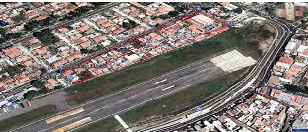
Figura 16. Vista de la cabecera de la pista del aeropuerto. Imagen tomada de Google Earth, 2016.
