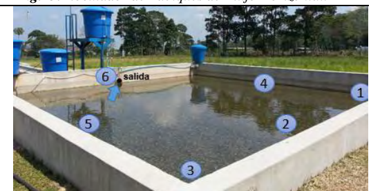
Fig. 1c: Filtro Grueso de Flujo Ascendente.
