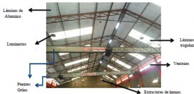
Fig. 3. Techo del Taller Metalmecánico.
