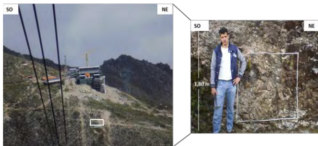
Figura 5.2. Macizo rocoso constituido por esquistos de la Asociación Sierra Nevada, ubicado en la base de la Estación Loma Redonda.
