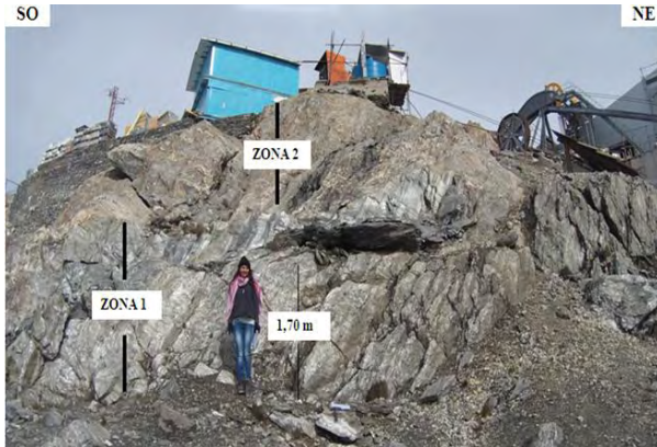
Figura 5.1. Macizo rocoso constituido por gneises y esquistos de la Asociación Sierra Nevada, ubicado en la base de la Estación Pico Espejo.
