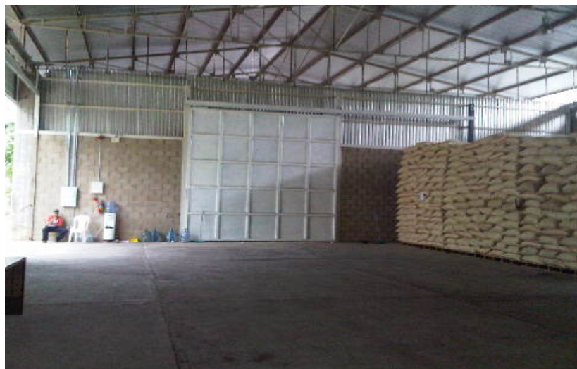
Figura 10. Infraestructura de almacenamiento.
