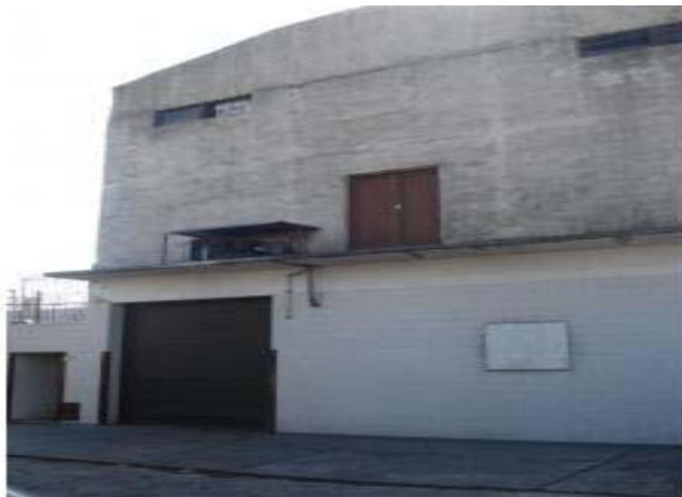
Figura 14. Falta de señalamiento.
