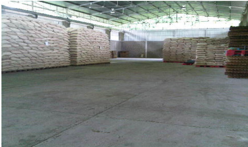
Figura 11. Infraestructura de almacenamiento.
