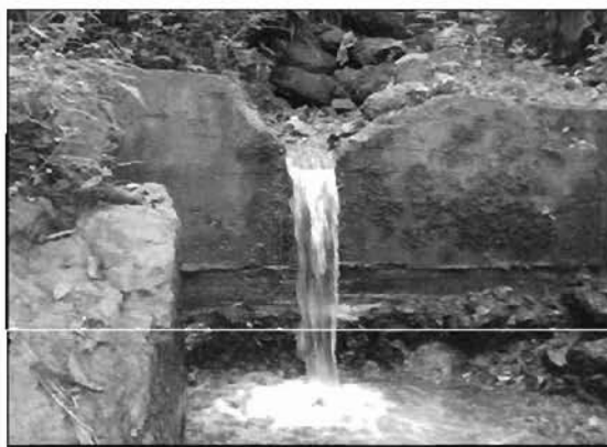
Figura 5.5: Estructura tipo vertedero.
