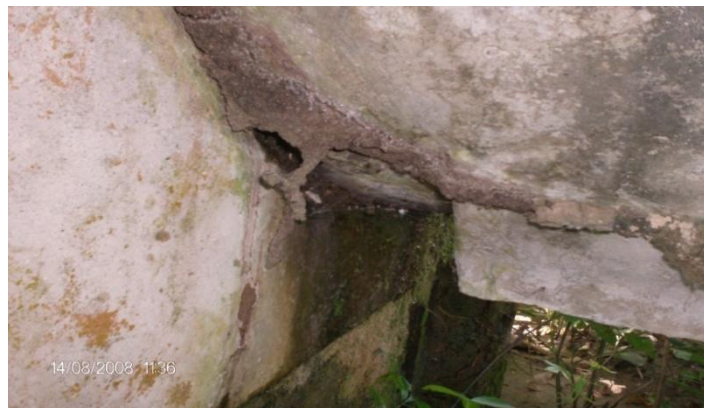
Figura 4.35 Filtraciones
