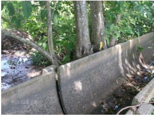
Figura 4.33 Levantamiento por árbol en canal hopensa
