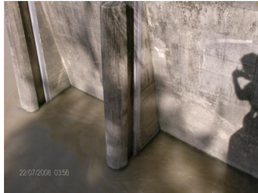
Figura 4.8 Entrada al desarenador
