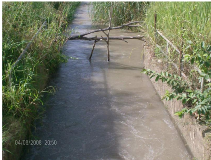
Figura 4.18 Obstrucción creada en el Canal principal
