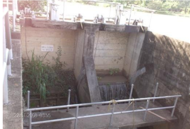
Figura 4.7 El desarenador
