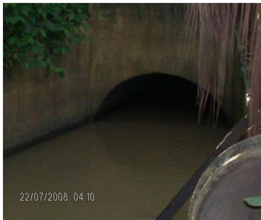
Figura 4.11 Salida del túnel
