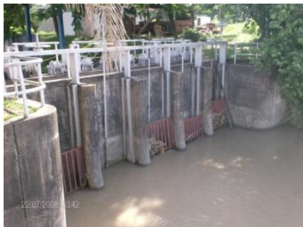
Figura 4.1 Obra de toma
