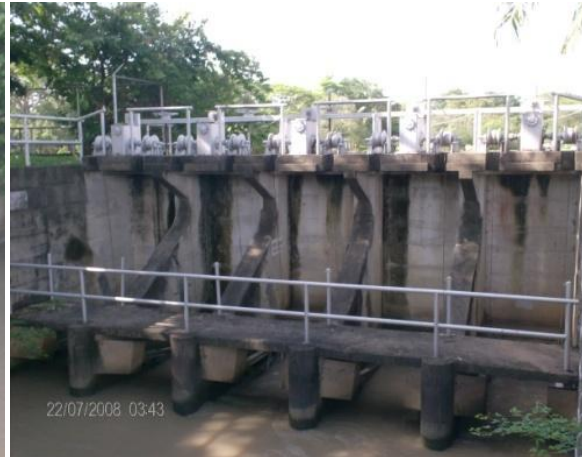
Figura 4.5 Compuertas de entrada
