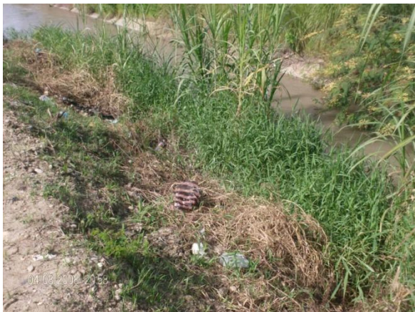
Figura 4.14 Losa fracturada y basura
