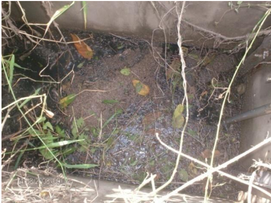
Figura 4.22 Sifón sedimentado.
