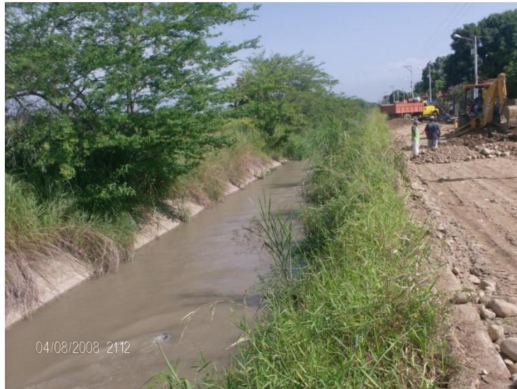
Figura 4.16 Vegetación en el canal principal
