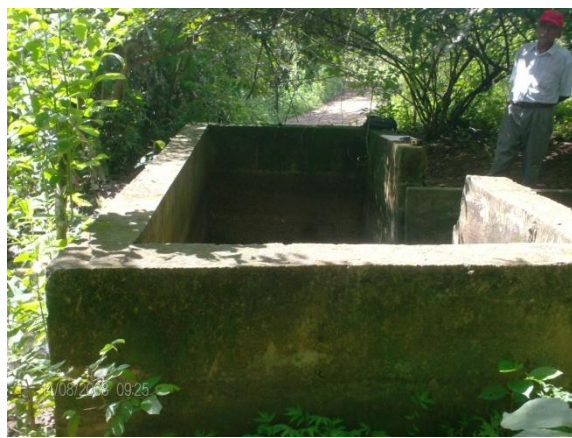
Figura 4.50 Sifón de toma de distribución
