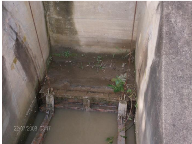
Figura 4.6 Compuerta de Entrada
