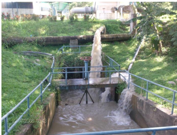
Figura 4.9 Entrada de aducción
