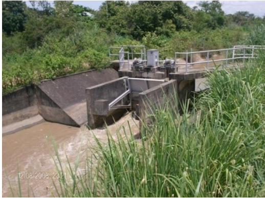
Figura 4.42 Retenciones en el canal principal
