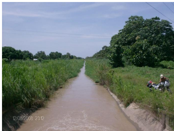
Figura 4.57 Berma de servicio dañada, parte derecha
