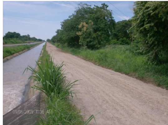
Figura 6.8 Berma de servicios, después
