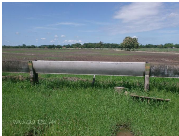
Figura 6.4 Canal hopensa, después
