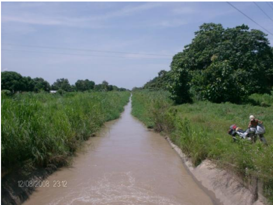
Figura 6.7 Berma de servicio, antes
