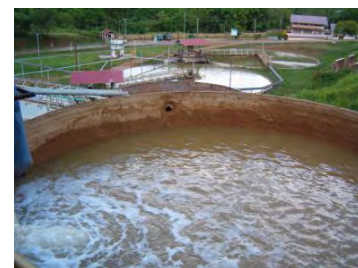
Tanque de cianuro
