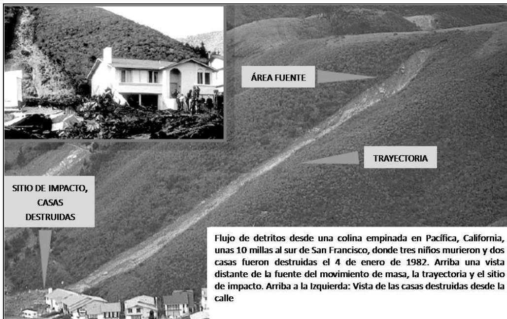
Figura 4. Área fuente, trayectoria y lugar de impacto de un movimiento de masa. Modificado de: USGS (1997).
