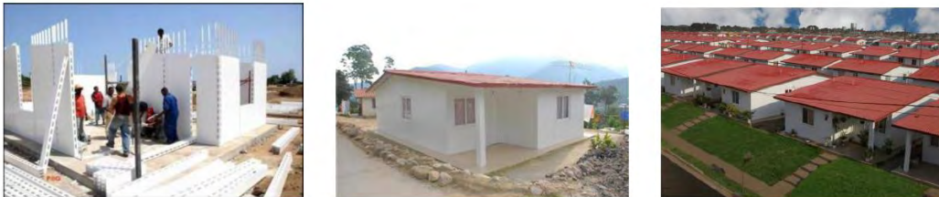
Figura 3. Petrocasa en construcción, Acabado final y proyecto masivo.
