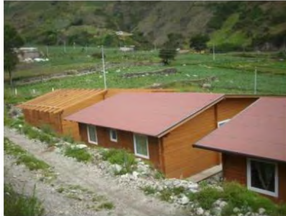
Figura 2. Viviendas de Madera construidas en el poblado La Venta Estado Mérida.
