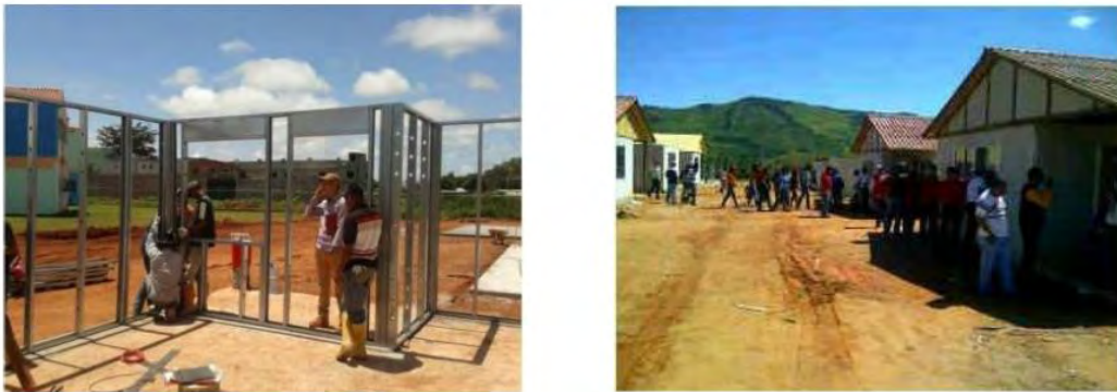
Figura 5. Vivienda en construcción con el sistema de fibrocemento y acabado final.
