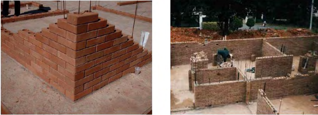
Figura 7. Sistema constructivo lego-bloque.
