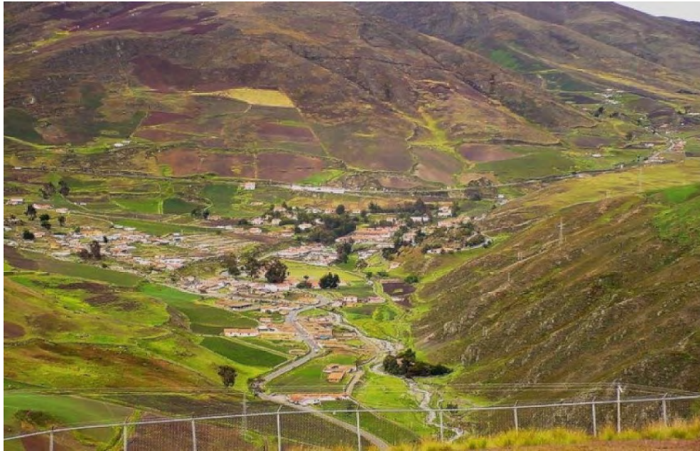
Figura N° 5. Asentamiento de comunidad (Apartaderos). Fuente: Elaboración propia.
