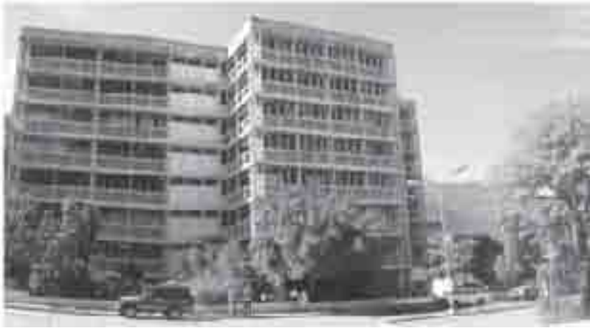
Edificio Administrativo de la Universidad de los Andes, Mérida
