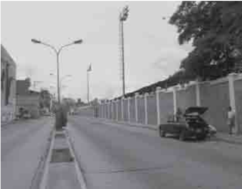
Muro de lindero del Estadio Lourdes de la Universidad de Los Andes.
