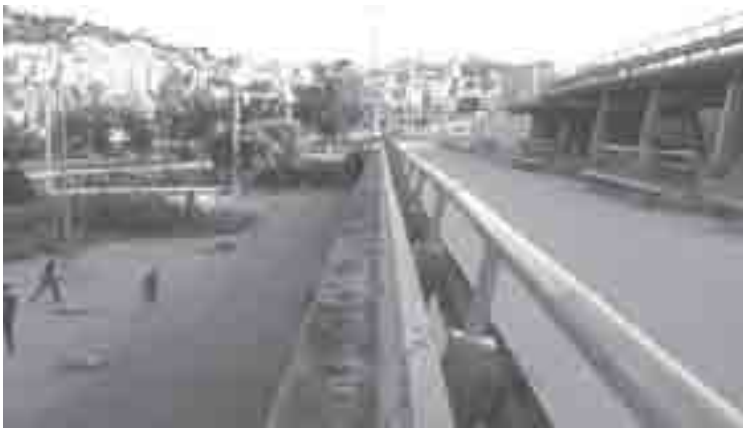
Nuevos elementos en torno al tema de los desniveles: terrazas, pérgolas, escaleras. Parque del Vall d' Hebron, Barcelona.
