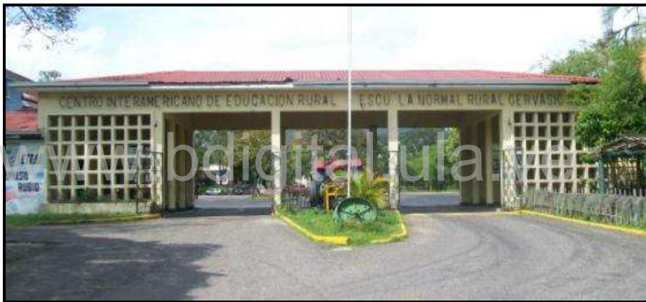
Fig. N°10 Fachada actual de la institución. Foto: CRA ETA Gervasio Rubio.
