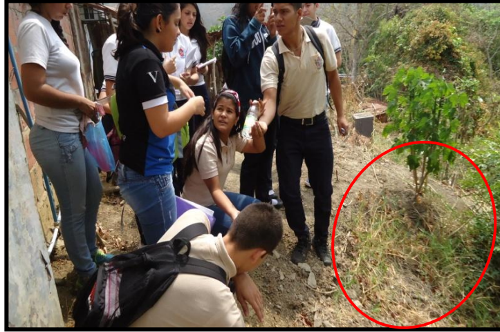
Figura53. Nicho de desprendimiento del movimiento en masa surgido en la vereda Tarabay
