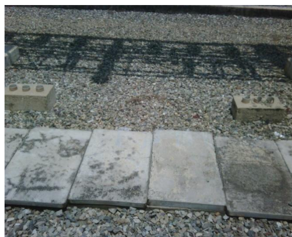
Fig.6.3. Tanquillas de los conductores que alimentarán los nuevos circuitos. S/E VIGIA I.
